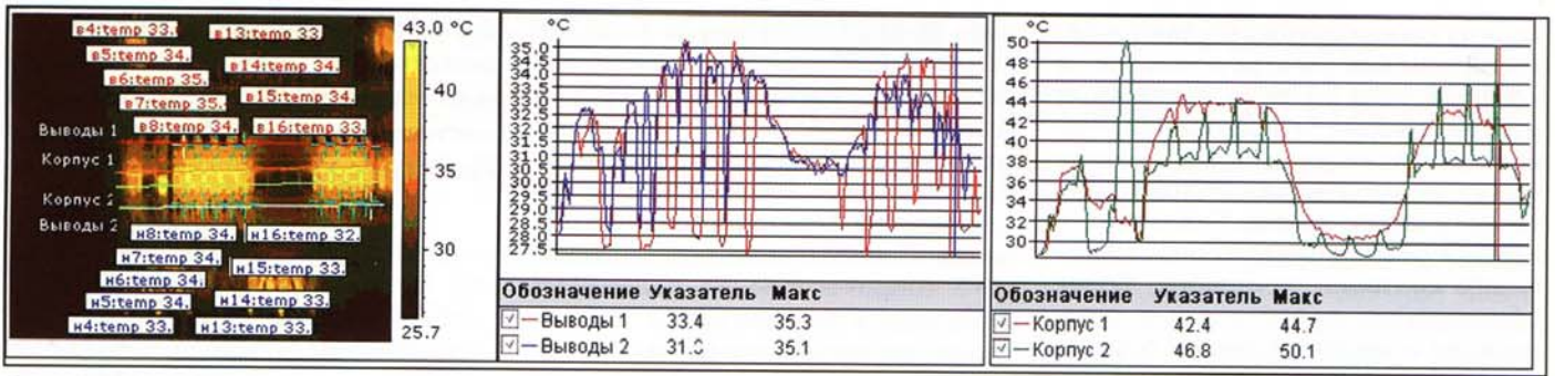
Рис. 1. Анализ теплового состояния современных распределительных устройств с уплотненным монтажом.
