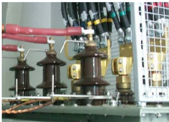
Рис. 15. Электросетевое хозяйство. Трансформаторная подстанция. Идентификация перегретых контактов
