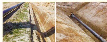
Рис. 3. Процесс прокладки волоконно-оптического кабеля-сенсора вдоль трубопровода
