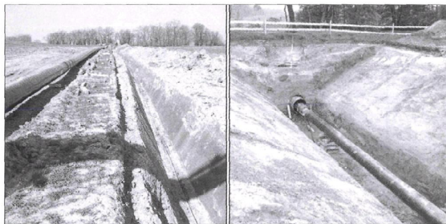
Рис. 3. Прокладка волоконно-оптического кабеля-сensors вдоль трубопровода
